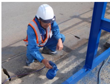
▲器用な手つきで塗装作業
