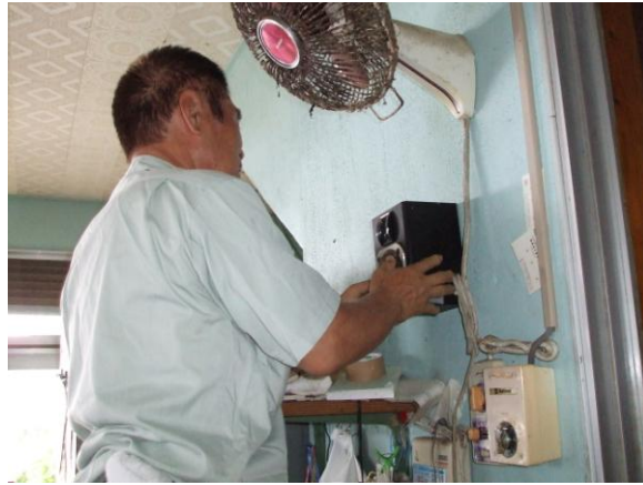
▲ オフトーク撤去作業
