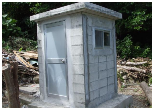
▲ 拝所の屋外トイレ完成
