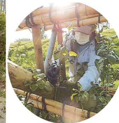
植栽の固定作業
