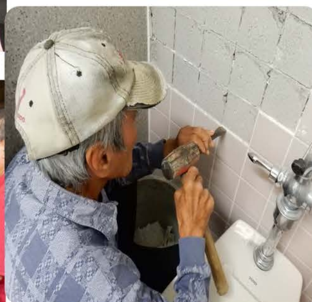
コツコツとタイルの張替補修
