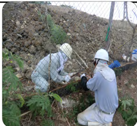
琉球ゴルフクラブの造成工事
