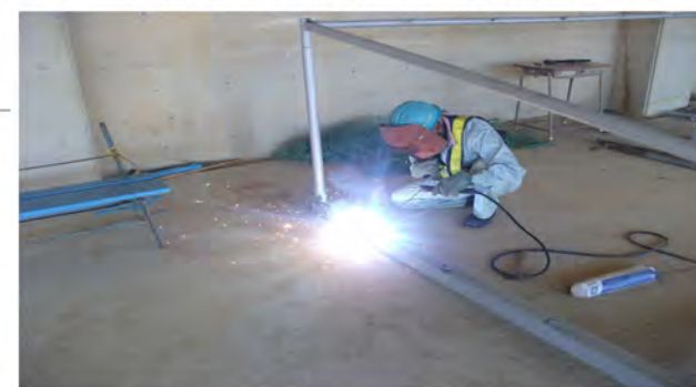
フェンス修復も素早く対応
