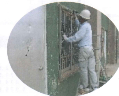
補修工事もていねいに
