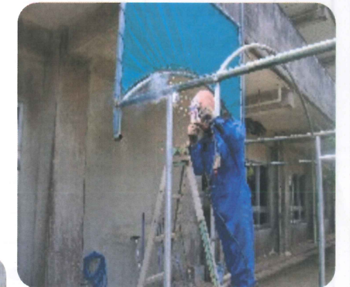
溶接工事もバッチリ
