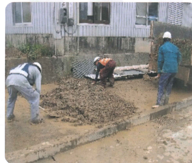
道路の土砂除去
