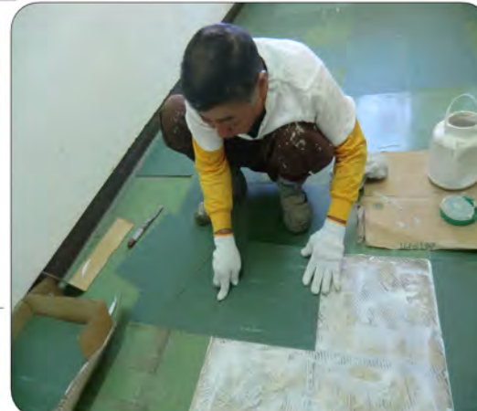
玉城中央公民館の床面の張り替え
